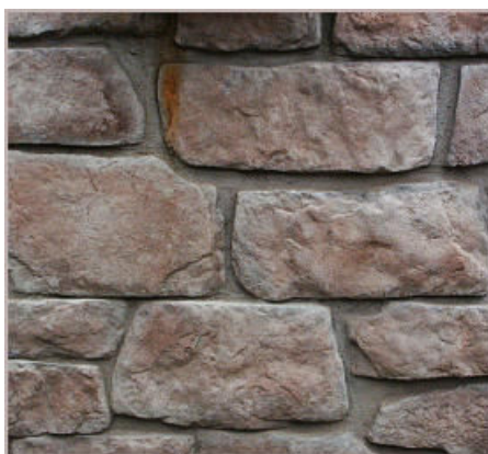
fot. Projektowana okładzina cokołu sali widowiskowej
