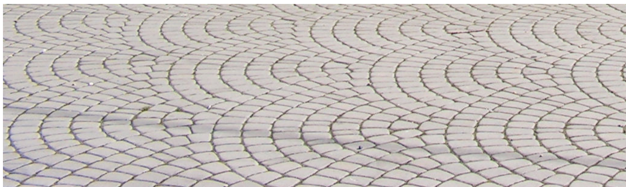
fot. Sposób układania bruku galicyjskiego wokół Pałacu
